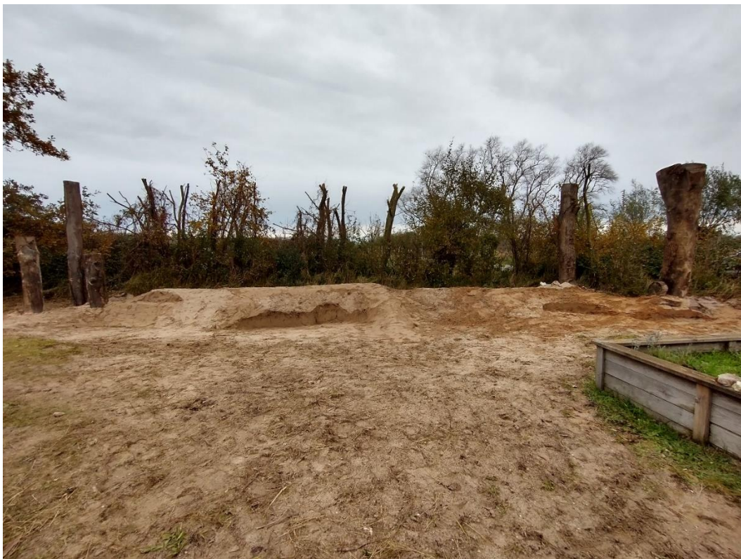
Figuur 5: Net aangelegde bijenburcht in de bijentuin van Knokke-heist. Hier werd, gezien de ligging in natuurgebied, gekozen voor een eenvoudige en natuurlijke aanleg met gebruik van gebiedseigen bodem. (foto Yannick Verstraete)
