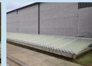
Fytobak voor zuivering reinigingswater Vergoeding: 4.000 euro
